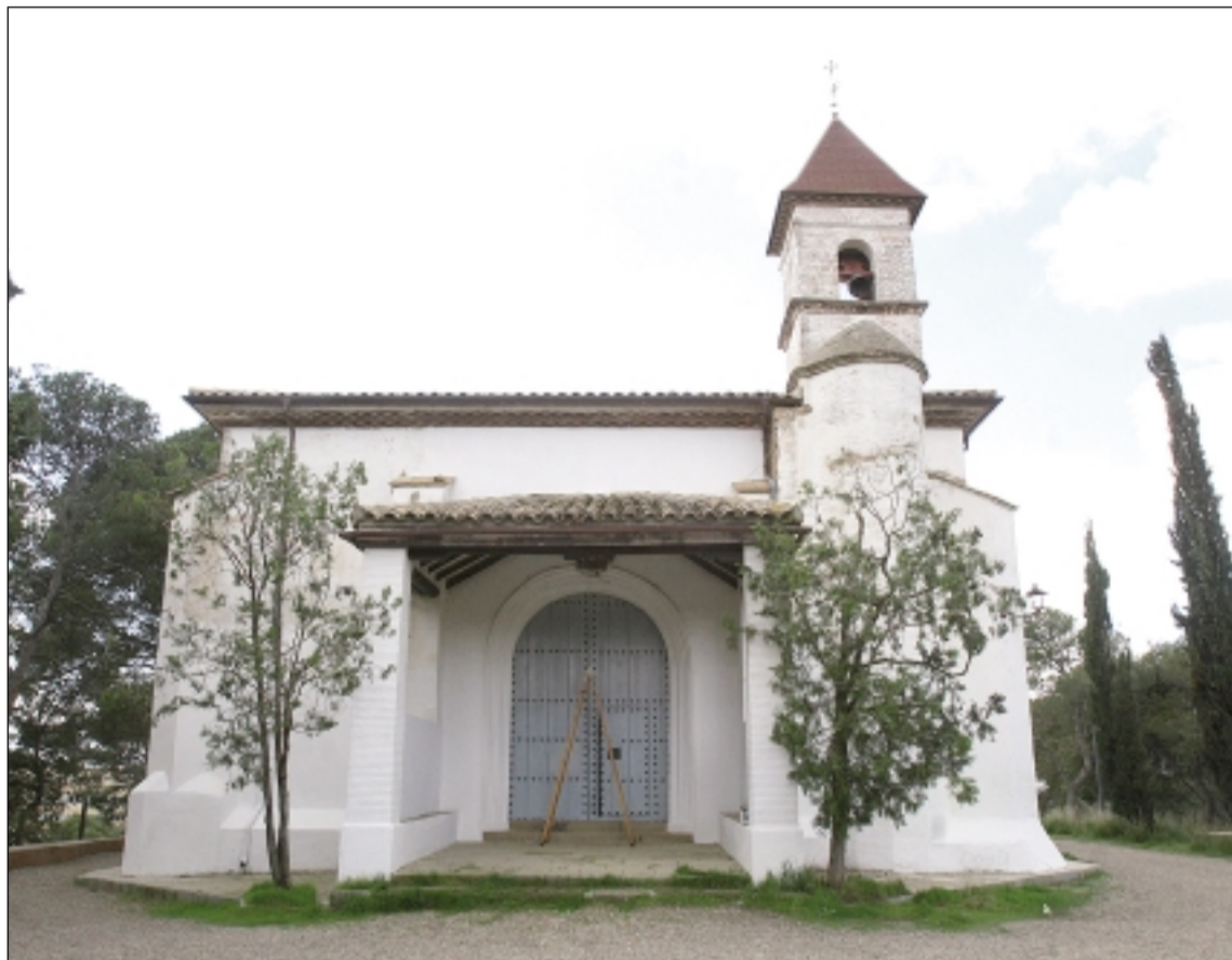
Durante los últimos días, se realizan retoques en el exterior e interior de la ermita, sobre todo de pintura. VÍCTOR IBÁÑEZ
