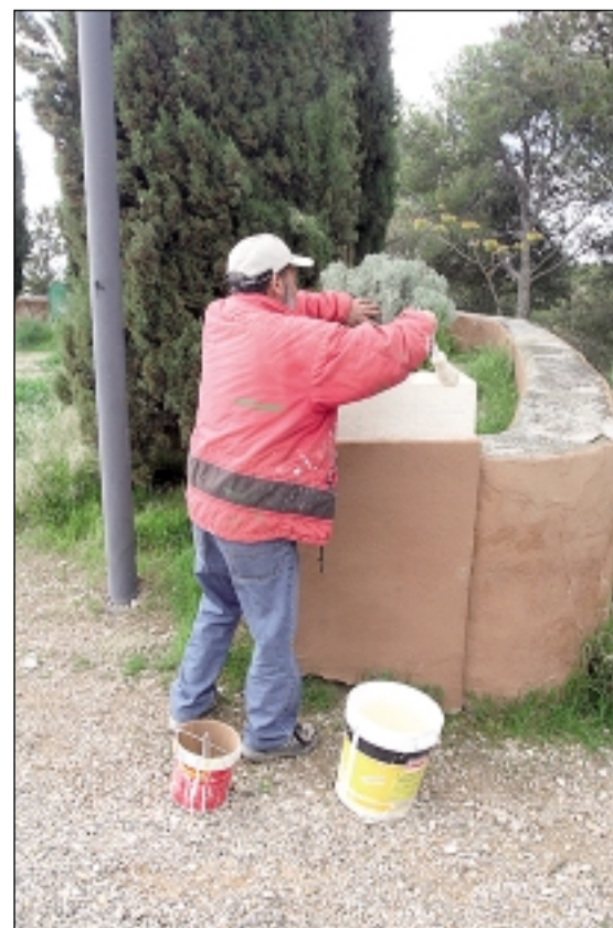
Labores de pintado por los alrededores de la ermita. V. IBÁÑEZ
